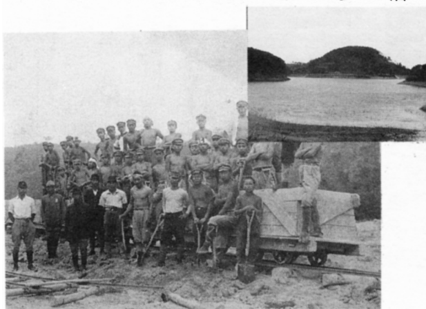
ふじ沼の工事（50年前）
