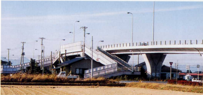
整備された道路
