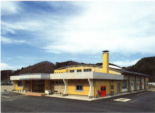
石川屋内温水プール
