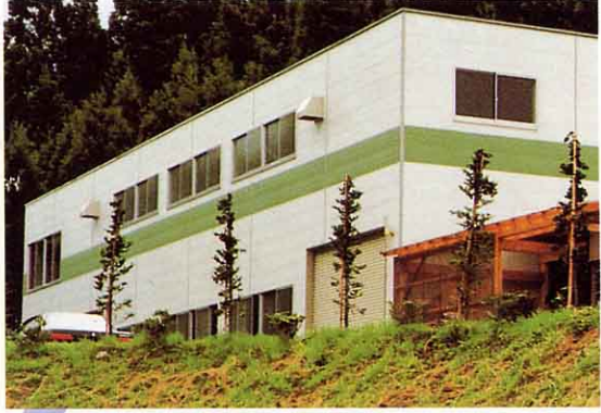
⑥きかいをつくる工場(関根製作所)
