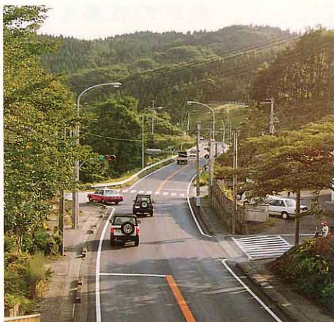
石川バイパス(石川山～猫啼間)完成
