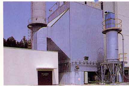
しゅうきゅうじきゅうき 電気集じん器・有毒ガス除去そう置 空気をよごさないためのしせつです。
