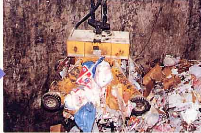
ごみクレーン たまったごみをもち上げます。
