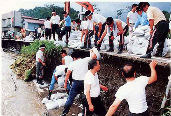
台風による被害の復旧作業にあたる水防団
