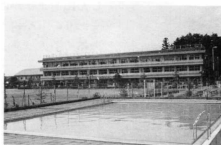
げんざいの玉川第一小学校
