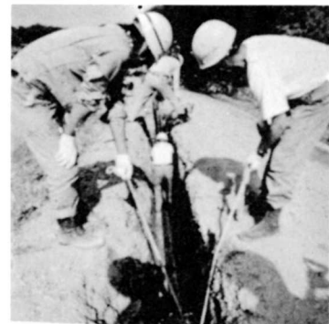
配水管の工事
