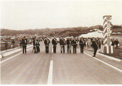
12 着工から8年。総延長2,450m全線開通
