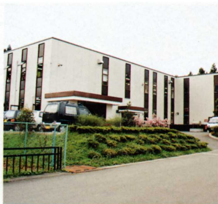
② 遠心分離器などをつくる工場(トミー工業)
