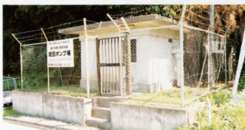
畑田ポンプ場
