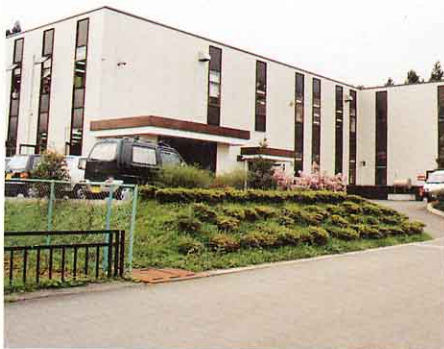
② 遠心分離器などをつくる工場(トミー工業)
