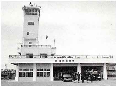
▼昭和49年 須賀川地方広域消防組合浅川出張所開設 すかがわちほうこういききょうぼうくわいあひあきがわちやうじょかいせつ
