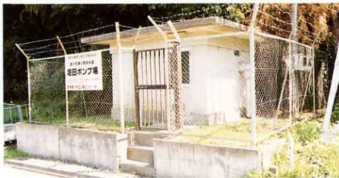
畑田ポンプ場
