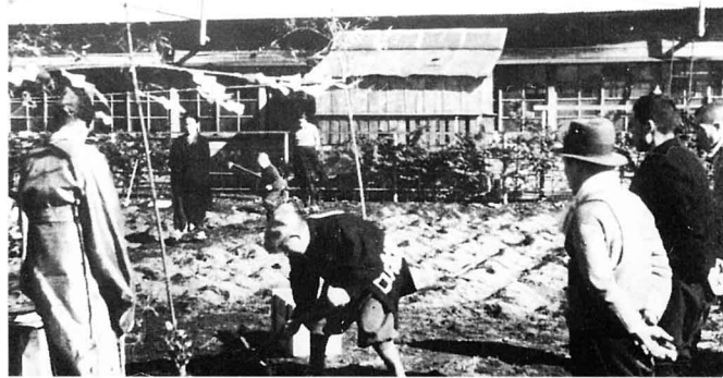
工場建設の地鎮祭
