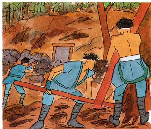
当時の工事のようす
