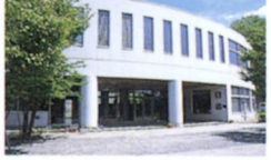
●要田中学校 第13回（平成6年度）福島県建築文化賞奨励賞受賞 第15回（平成7年度）東北建築賞作品賞受賞
