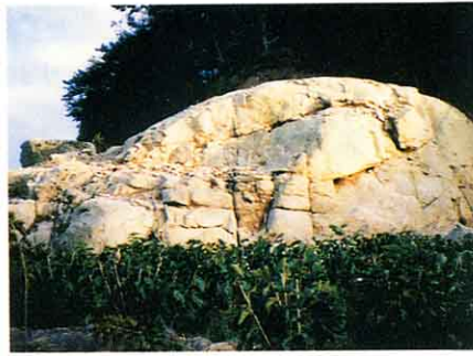
御木沢地区平沢地内のまるいカコウ岩の亀裂
