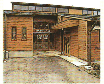
■屋内ゲートボール場
