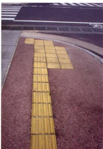
点字ブロック
