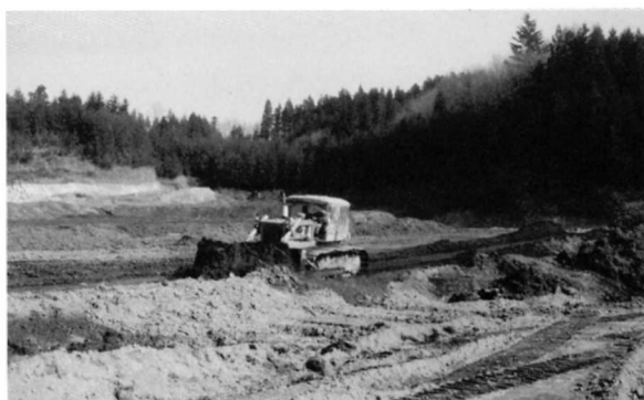
ブルドーザーによる畑の整地
