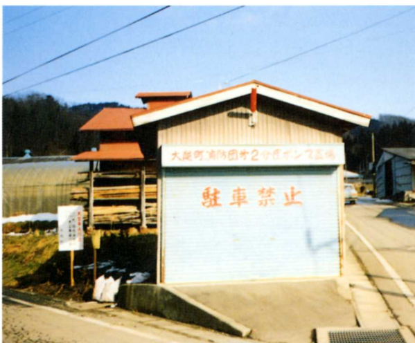
自動車ポンプ置場
