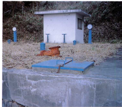
たて 館配水池
