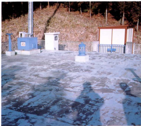
みやまへ 宮の前配水池
