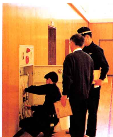
消火せつびの点検
