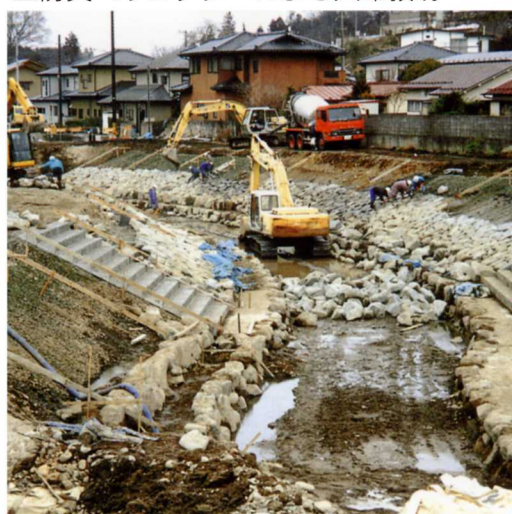
▲水害防止のための河川工事
