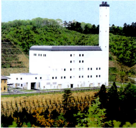
▲ごみしり場（西白河地方クリーンセンター）
