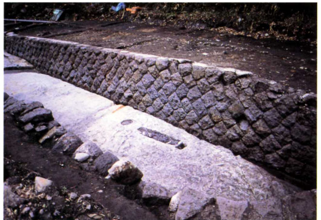
水車廃業後の石積（西側）
