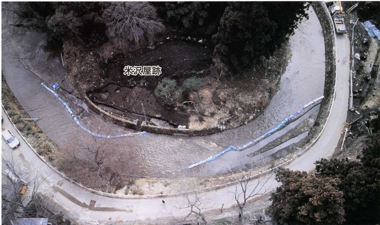
米沢屋跡遠景 しみずやから続く水路は米沢屋を通り、市役所の方まで延びていきます。
