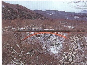
阿武隈川に架かるアーチ式の鉄橋。長さ81m、谷底までの高さは約50m。この橋を中心とした約4kmの間は雪割渓谷と呼ばれており、とりわけ春、秋の景観は素晴らしいです。
