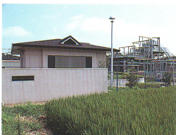
下水道施設(大平浄化センター)
