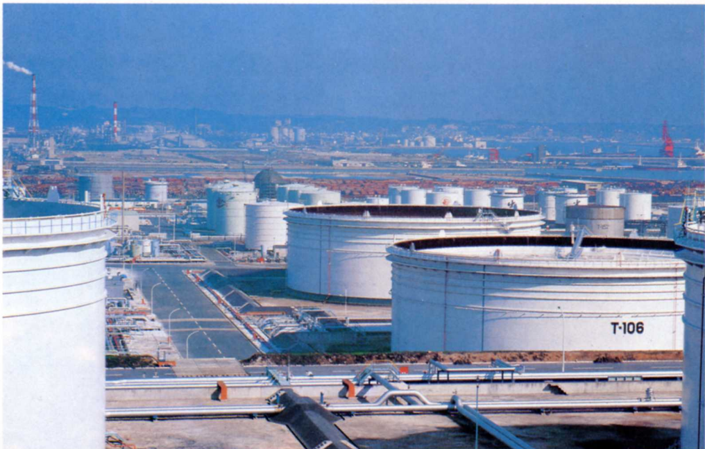
石油貯蔵タンク いわき市
