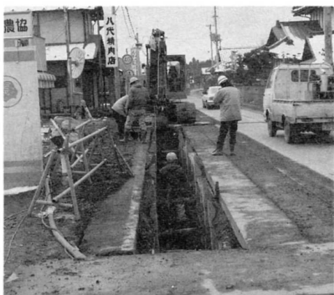
ちやくちやく進められている下水道工事
