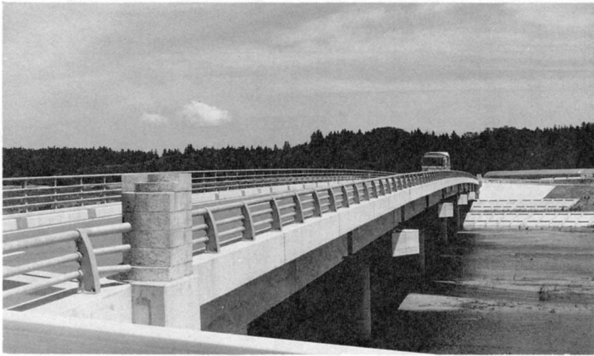
立派にできあがった滑津橋
