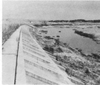
よくなった堤防
