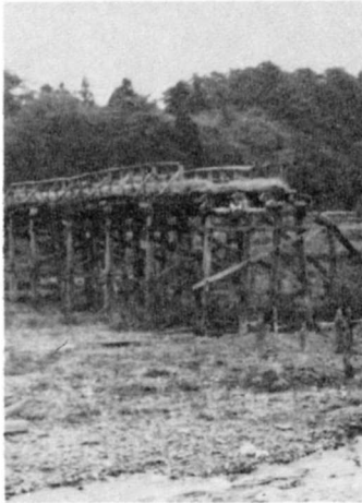
流された吉岡橋 (昭和40年9月)
