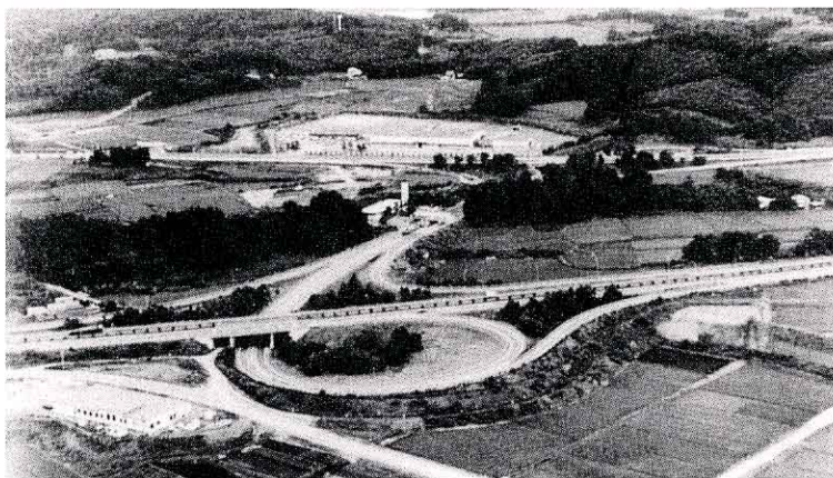
矢吹インターチェンジ
