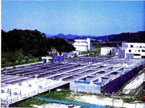
県中浄化センター
