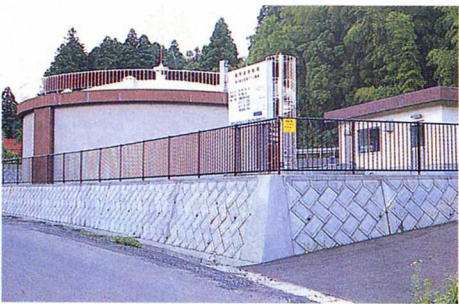
上水道配水池
