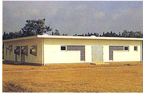
集落排水処理場
