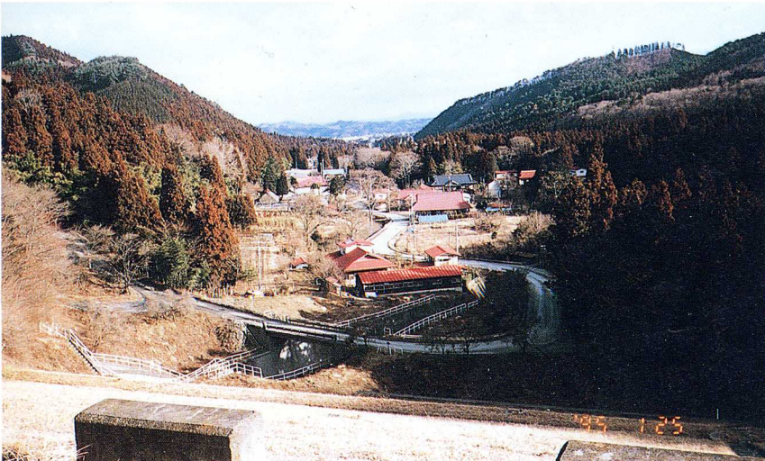
犬神ダムから 犬神地区をみたところ
