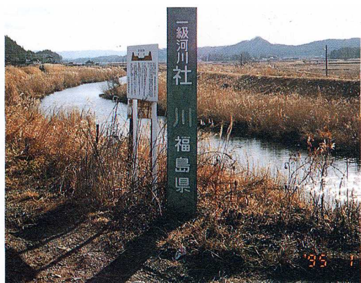
かいしゅう やしろがわ 改修工事後の社川（平成7年）
