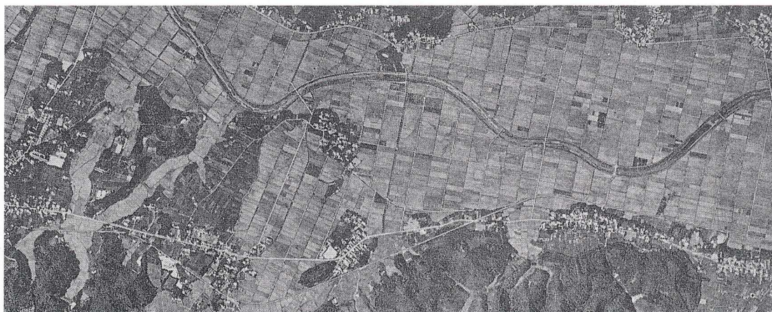
改修工事後の社川のようす やしろがわ
