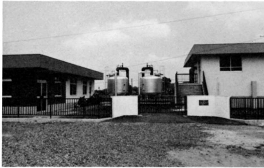
配水池（宮替地内）
