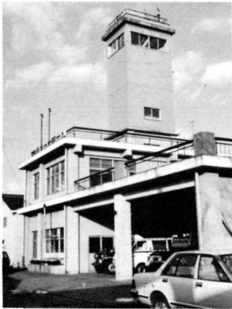
矢吹消防署東分署
