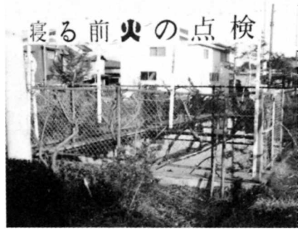
防火水そう(消防署前地区)
