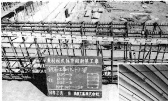
体育館の鉄筋工事
