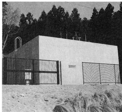
上新城配水池
