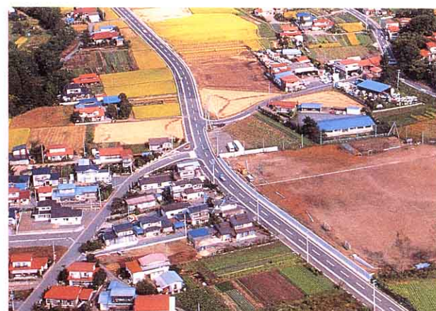
町道中居丸内線 西中居上空から
