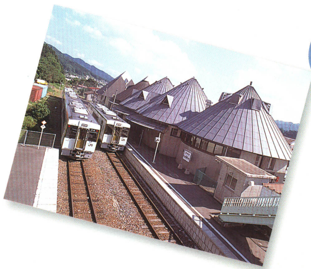
JR駅舎・町立図書館と併設したコミュニティプラザ
