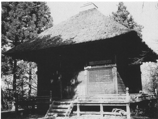
常世観音堂正面
